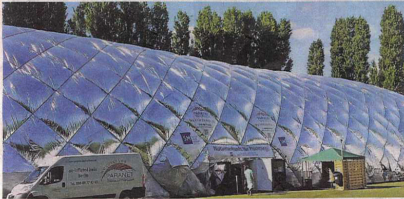
Das Berliner Unternehmen Paranet hat zwei Traglufthallen an die Stadt vermietet. Eine Halle kommt an die Koblenzer Straße.
