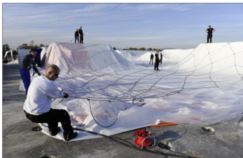
Vor dem Aufblasen wird das Drahtseilgeflecht ausgelegt. Unter der Folie zeichnen sich die zuvor aufgestellten Sanitär- und Bürocontainer ab.
