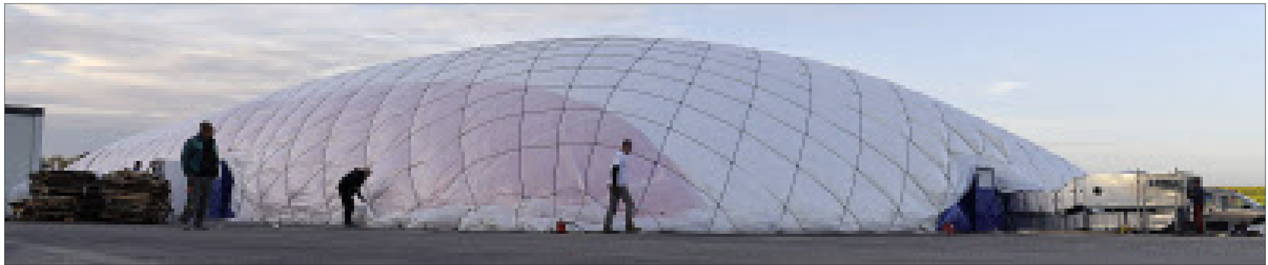
Die Hülle steht. Das wabenförmige Geflecht aus Drahtseil ist im Boden verankert und gibt der neuneinhalb Meter hohen Traglufthalle Form und Halt. Das Gebläse (rechts) pumpt ständig Luft hinein. – Fotos: Roland Binder
